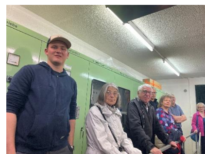
Im Grundwasserpumpwerk Schachen II
